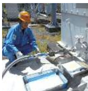
微量PCB無害化処理 (課電自然循環洗浄)
