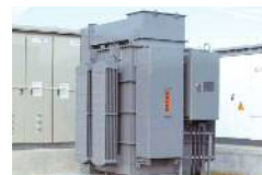
静止型無効電力補償装置 (SVC)
