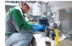
変圧器からの絶縁油採油風景
