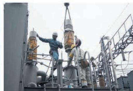
高圧ブッシング取付工事 High-pressure bushing installation work
