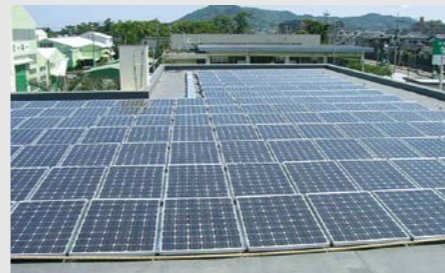
本社屋上の太陽光パネル
