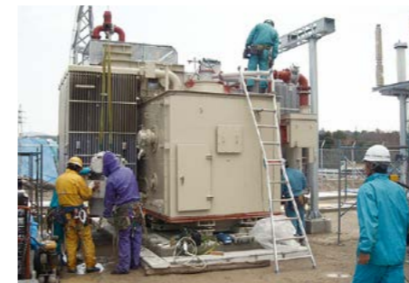
オーバーホール An overhaul
