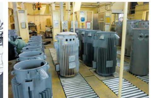
変圧器部分修理工場 Transformer parts repair facility
