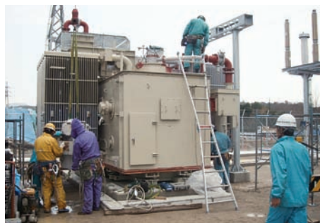
オーバーホール An overhaul
