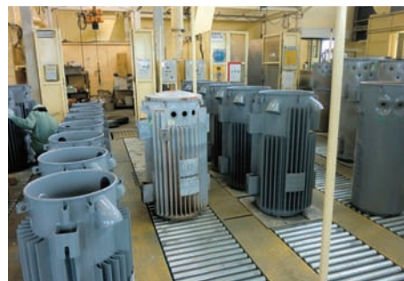
変圧器部分修理工場 Transformer parts repair facility
