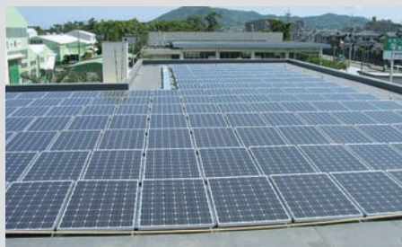
本社屋上の太陽光パネル
